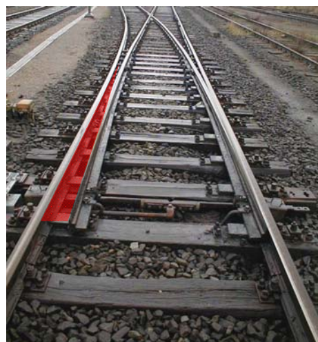
Abbildung 5: An Weichen besteht Quetschgefahr
