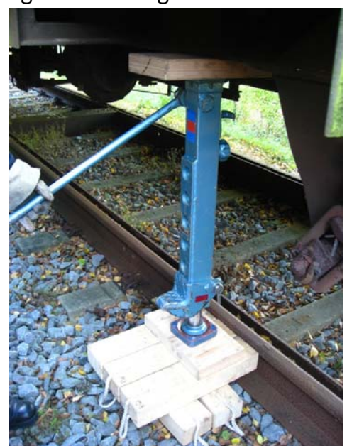
Abbildung 43: Fahrzeuge mit Feuerwehrggerät anheben
