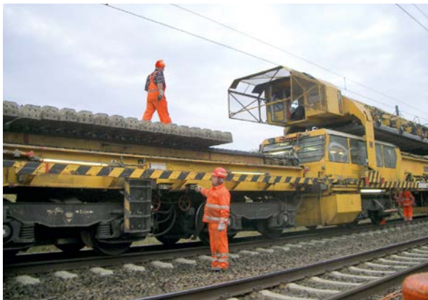
Abb. 8-8: Bei Arbeiten auf dem Umbauzug muss die Oberleitung ausgeschaltet und bahngeerdet sein.
