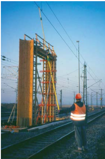
Abb. 4-4: Feststellen der Spannungsfreiheit durch Fachpersonal vor Arbeitsbeginn.
