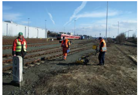
Abb. 12-25: Kampfmittelerkundung in einem Bahnhof bei gesperrtem Nachbargleis.
