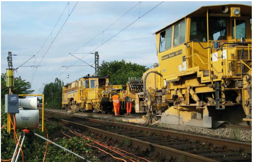
Abb. 9-1: Stopfmaschine (im Hintergrund, mit Messtrupp) und Schotterplaniermaschine.
