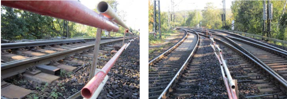
Abb. 2-8: Geeignete Feste Absperungen können auch im Bereich von Weichenzungen montiert werden (links). Unterbrechungen der Feste Absperungen in Weichenbereichen werden mit sichtbarer Abgrenzung kenntlich gemacht und während der Arbeiten z. B. mit Absperrosten gesichert (rechts).
