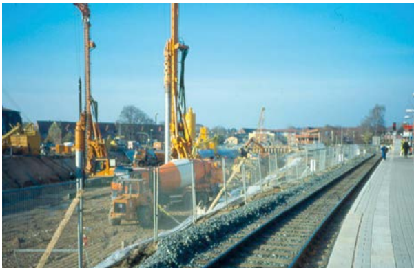
Abb. 2-11: Bauzaun als Feste Absperrung zwischen Arbeitsbereich und Gleisanlage.
