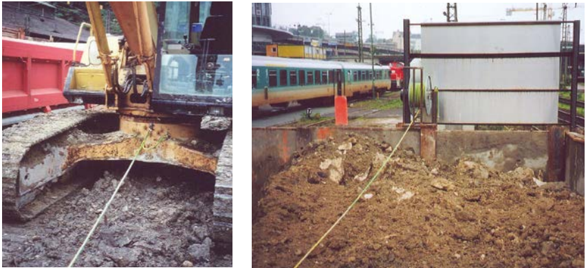
Abb. 4-6: Bagger mit Kabeltrommel zum Aufwickeln der Schlepperde.
