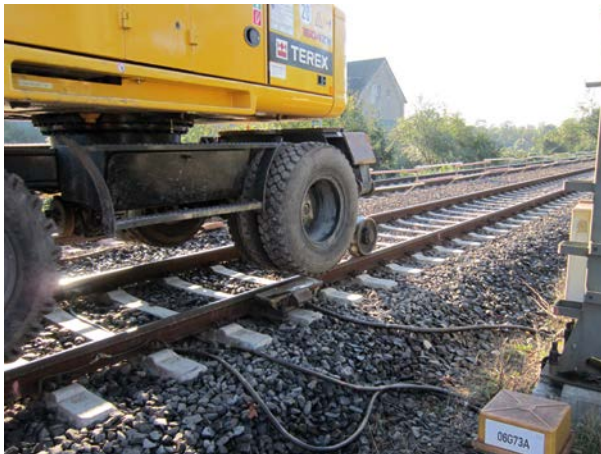
Abb. 7-12: Ausheben des Mobilfahrwerks am Indusi-Gleismagnet.
