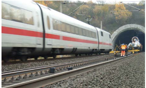
Abb. 11-1: Schienenwechsel im Tunnel bei ortsfest aufgestellter (oben) und mobil mitgeführter (rechts) technischer Lüftung.
