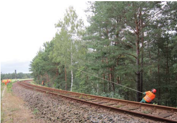
Abb. 12-24: Beim Fällen von Bäumen ergibt die Gefährdungsbeurteilung, dass individuelle Warngeräte kein geeignetes Sicherungsverfahren sind.
