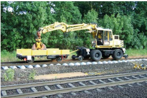
Abb. 7-3: Bei Transporten mit dem Zweibegebagger sollten Bahnwagen eingesetzt werden, um auf Mitgänger zum Führen angeschlagener Lasten verzichten zu können.
