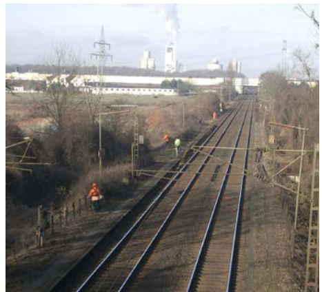
Abb. 12-22: Vegetationspflege mit Freischneidern: da die Beschäftigten sich längs des Gleises weit verteilt haben, ist eine Sicherung mit Absperreposten nicht möglich. Die Wahrnehmbarkeit der akustischen Warnsignale muss gewährleistet sein.
