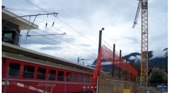
Abb. 4-8: Markierungen zur Kenntlichmachung des Schutzabstandes bei Kranarbeiten in Fahrleitungsnähe.
