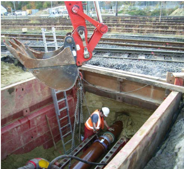
Abb. 12-7: Rohrvortrieb unter einer Gleisanlage: Eine feste Abspernung wäre erforderlich, um das unbeabsichtigte Hineingeraten in den Gleisbereich zu verhindern und die Grenze des Arbeitsbereichs zu kennzeichnen. Der Stirnverbau muss ergänzt werden.
