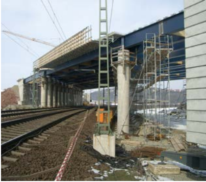
Abb. 12-17: Geschlossene Schutzwand über der Gleisanlage, um Materialabsturz und Gefährdung durch die Fahrleitung auszuschließen (Pfeilerbereiche: 3-teiliger Seitenschutz ist zu ergänzen). Die Höhe der Schutzwand richtet sich nach [38].
