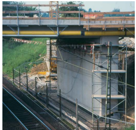
Abb. 1-1: Beispiel zum Gleisbereich: Beim Hantieren mit Gerüstrohren neben dem Gleis besteht die Gefahr, in den durch Druck- und Sogwirkungen gefährdeten Bereich hineinzugehen oder den Schutzabstand zu unter Spannung stehenden Teilen der Fahrleitungsanlage zu unterschreiten. Der Gleisbereich umfasst in diesem Fall auch die Arbeitsplätze der Gerüstbauer. Bei der DB schließt der Gleisbereich den Gefahrenbereich ein (vgl. Anhang 3).
