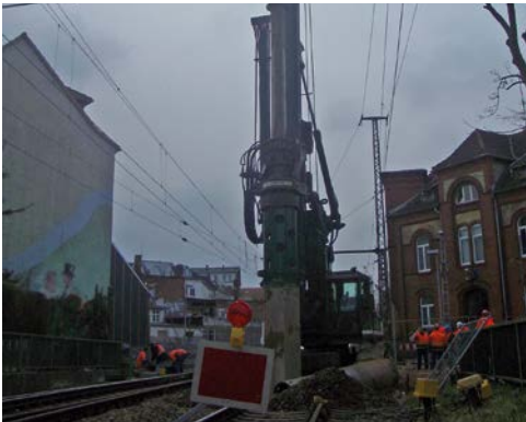
Abb. 12-6: Einsatz eines Drehbohrgerätes im Gleisbereich.
