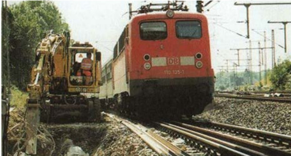
Abb. 7-20: Zweiwegebagger auf Mobilfahrwerk neben Betriebsgleis.
