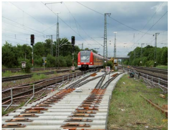
Abb. 3-9: Feste Abspernung als Sicherung für den Vormontageplatz einer Weiche.
