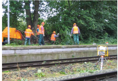
Abb. 12-21: Vegetationspflege: Sicherung mit händisch mitgeführten Signalgebern.
