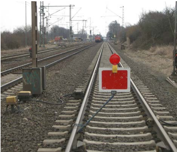
Abb. 2-1: Kennzeichnung einer Gleisstelle, die vorübergehend nicht befahren werden darf, durch Wärterhaltscheibe.
