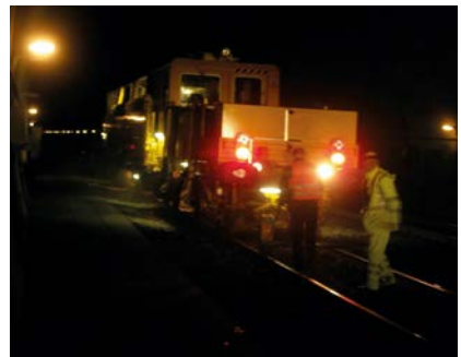
Abb. 2-17: Einsatz von Absperrposten für Arbeitsstellen, die örtlich eng begrenzt sind: Arbeiten am Kabelschacht (links) und Messtrupp hinter der Stopfmaschine (rechts).
