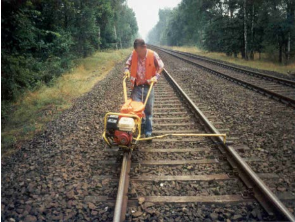
Abb. 6-1: Bei Arbeiten mit Maschinen, z. B. Schraubmaschinen, muss das Arbeitsgleis gesperrt sein. Warnwesten sind geschlossen zu tragen.
