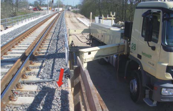
Abb. 12-4: Erdungsanschluss für eine Betonpumpe.
