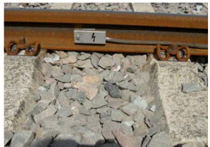
Abb. 4-12: Rückleiter und Erdungsleiter, z. B. von elektrischen Weichenheizanlagen: die Abdeckbleche dürfen nur durch anlagenspezifisch unterwiesene Elektrofachkräfte mit Beauftragung durch den Anlagenverantwortlichen gelöst werden.
