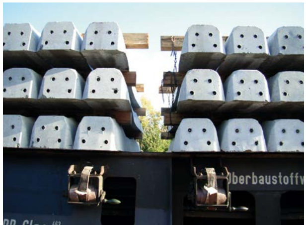
Abb. 8-10: Bei Aufenthalt auf Waggons oder Maschinen muss der Schutzabstand zur Oberleitung eingehalten werden. Bei einer Oberleitungshöhe von 4,95 m darf die Standhöhe über Schienenoberkante max. 1,45 m betragen. Arbeiten mit aufragenden Gegenständen sind nicht zulässig.
