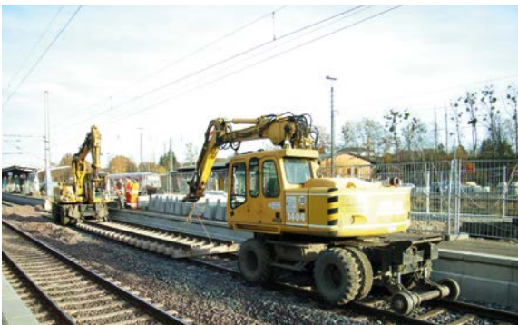
Abb. 7-5: Transport eines Gleisjochs: die Rückwärtsfahrt ist unvermeidbar.
