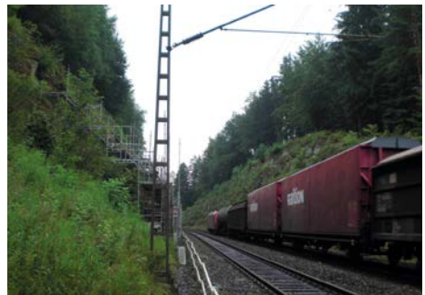
Abb. 12-13: Arbeitsgerüst für Hangsicherungsarbeiten in der Nähe des Gleisbereichs.
