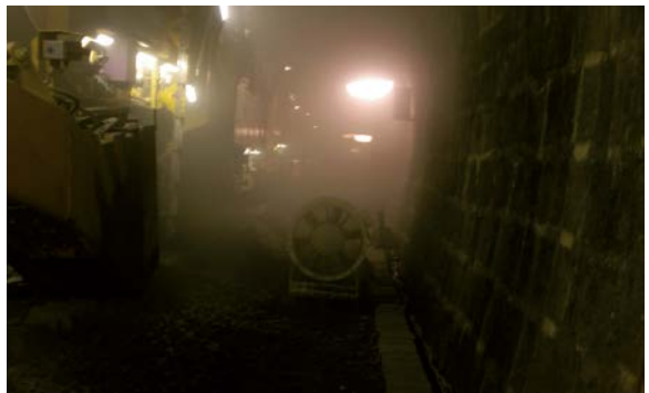
Abb. 11-2: Technische Lüftung bei Bettungsreinigungsarbeiten im Tunnel.
