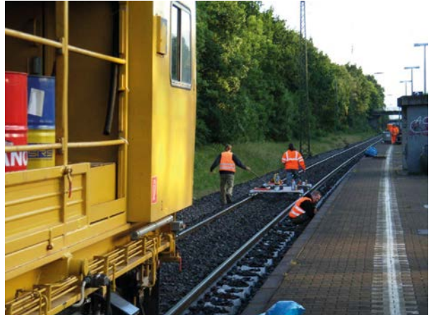
Abb. 9-3: Versetzbewegung einer Stopfmaschine im Baugleis nach rück- wärts. Der in Bewe- gungsrichtung vordere Führerstand ist hier nicht besetzt.
